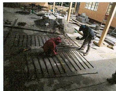
Foto 6: Reparación de ventanas y balcones
