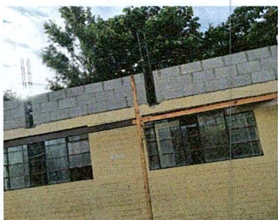
Foto 5: Levantamiento de pared en mojinete
