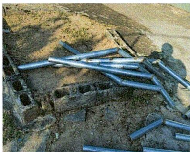
Foto 4: material para la colocacion de malla en muro perimetral
